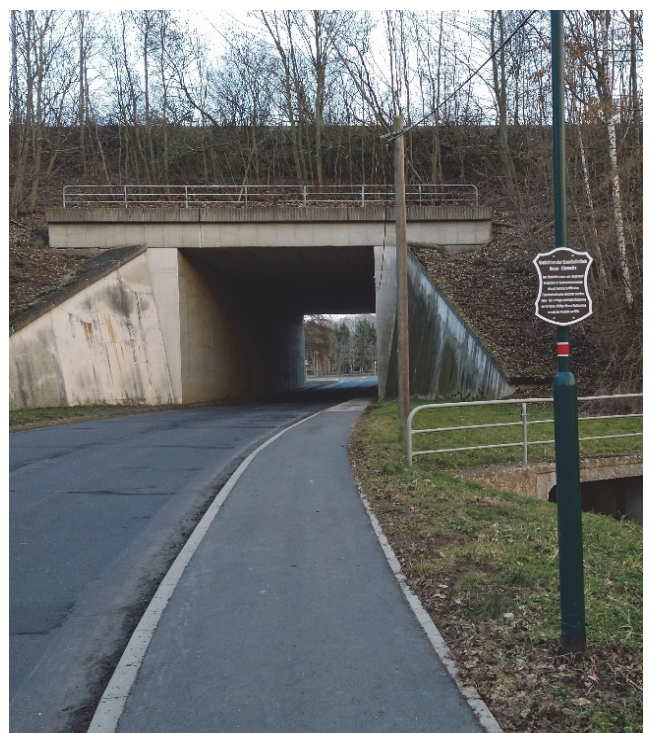
Schildstandort am Viadukt Crossen
